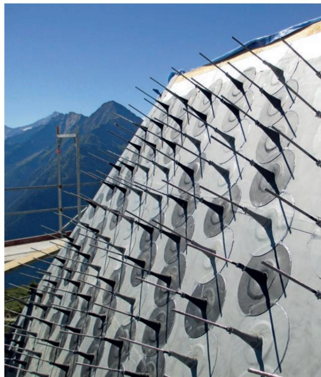
▲ Zur Befestigung der Stahlfassade wurden 2280 Gewindestangen montiert und mit Blitzschutzdurchgängen in die Abdichtung integriert
