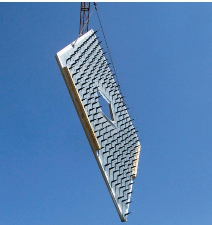
▲ Die Capella Granata besteht aus zwölf rhombenförmigen Brettsperrholzelementen, die mit einer Kunststoffbahn abgedichtet wurden
