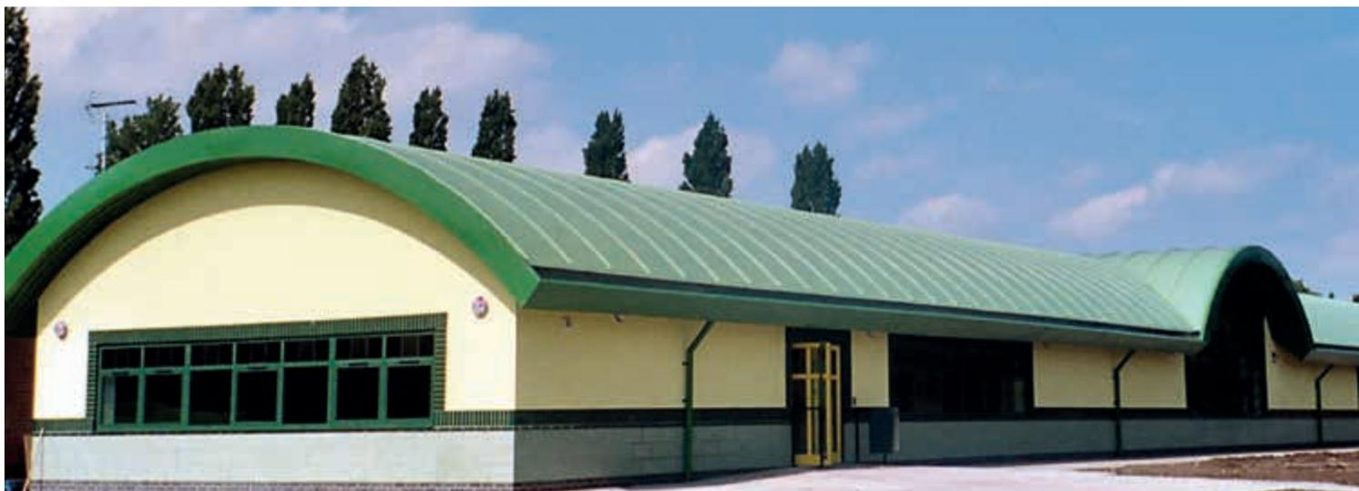
Das Rhenofol-Stehfalzprofil ist ein Hohlkammerprofil aus dachbahnidentischem Rohstoff zum Aufbringen auf Rhenofol CV. Länge 4 m.
